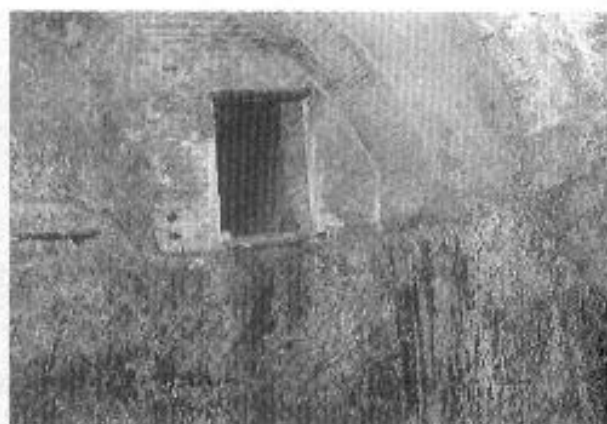
Wejście do pomieszczenia i tunelu nr. 8
